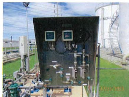
ภาพที่ 2-14 ระบบ Online Monitoring บริเวณบ่อพักน้ำทิ้งรวม
