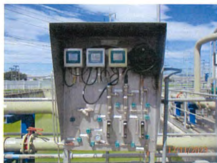
ภาพที่ 2-16 ระบบ Online Monitoring บริเวณบ่อพักน้ำหล่อเย็น
