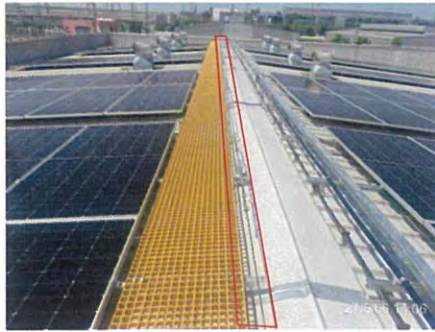
ภาพที่ 2-65 สาย Life Line บริเวณหลังคาอาคาร
