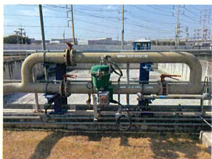
ภาพที่ 2-18 วาล์วควบคุมการปล่อยน้ำทิ้งจากหอหล่อเย็น
